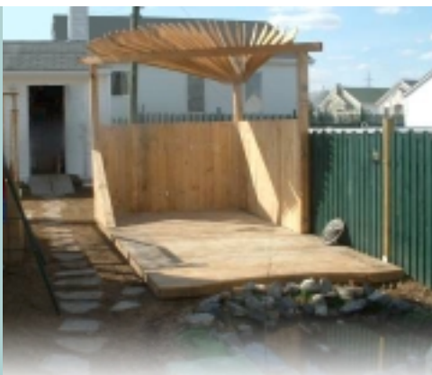
Structure faite à partir de bois recyclé.
